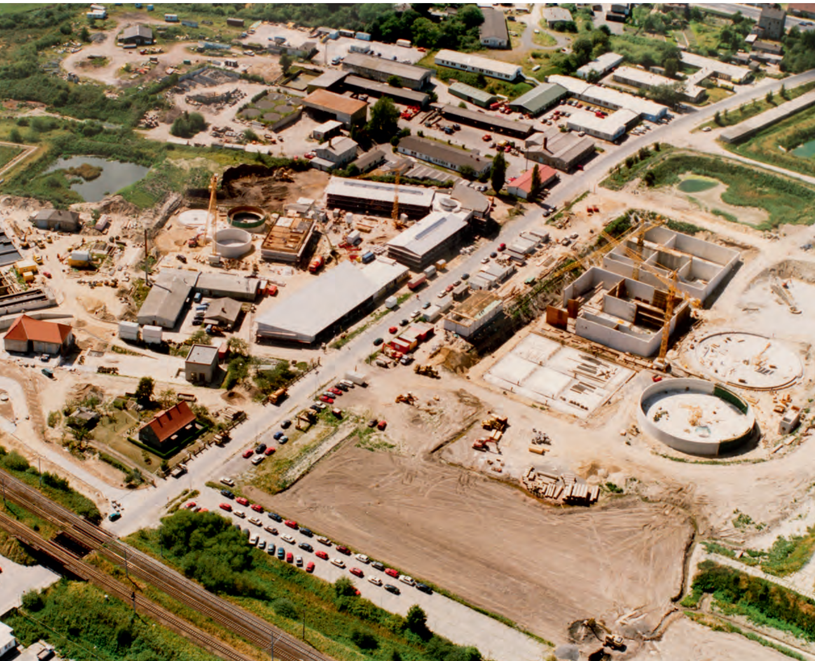
Kläranlage Stralsund im Bau
